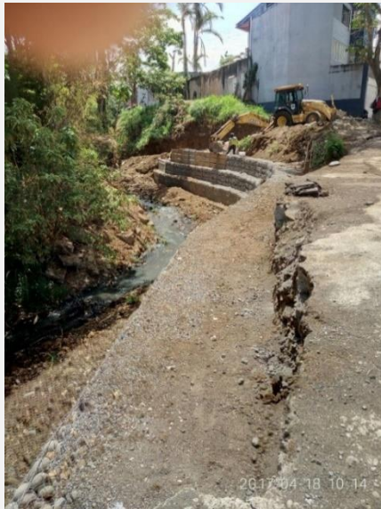
Photo 2. Des travaux faits sur le lit de la rivière
