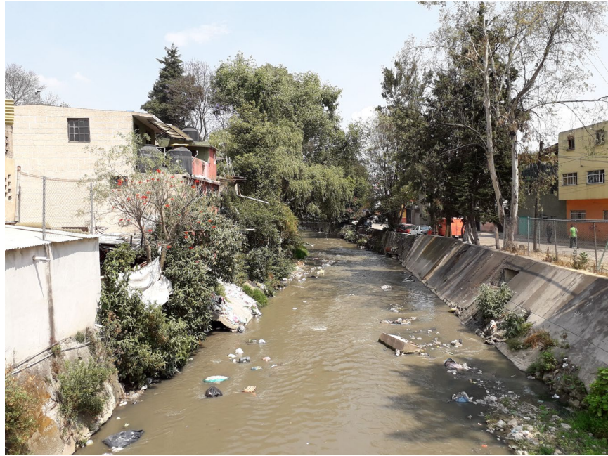
Figura 17. Poca continuidad en la traza, lo cual afecta la movilidad en la zona
